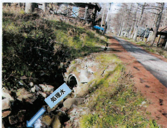
【処分場下流水路】
